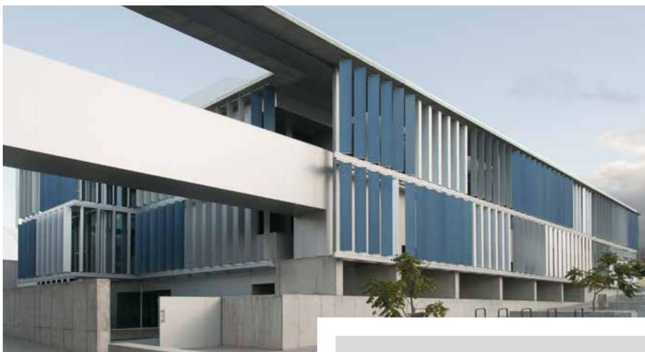
**L**os sistemas de lamas de protección solar de CORTIZO se presentan como una eficaz solución para controlar la incidencia de los rayos del sol en la temperatura interior de un edificio. La radiación del sol es absorbida y reflejada por estas lamas exteriores, favoreciendo la eficiencia energética del inmueble, al disminuir la necesidad de refrigeración artificial. Al mismo tiempo, funcionan como elemento decorativo aportando una estética vanguardista a la fachada.
