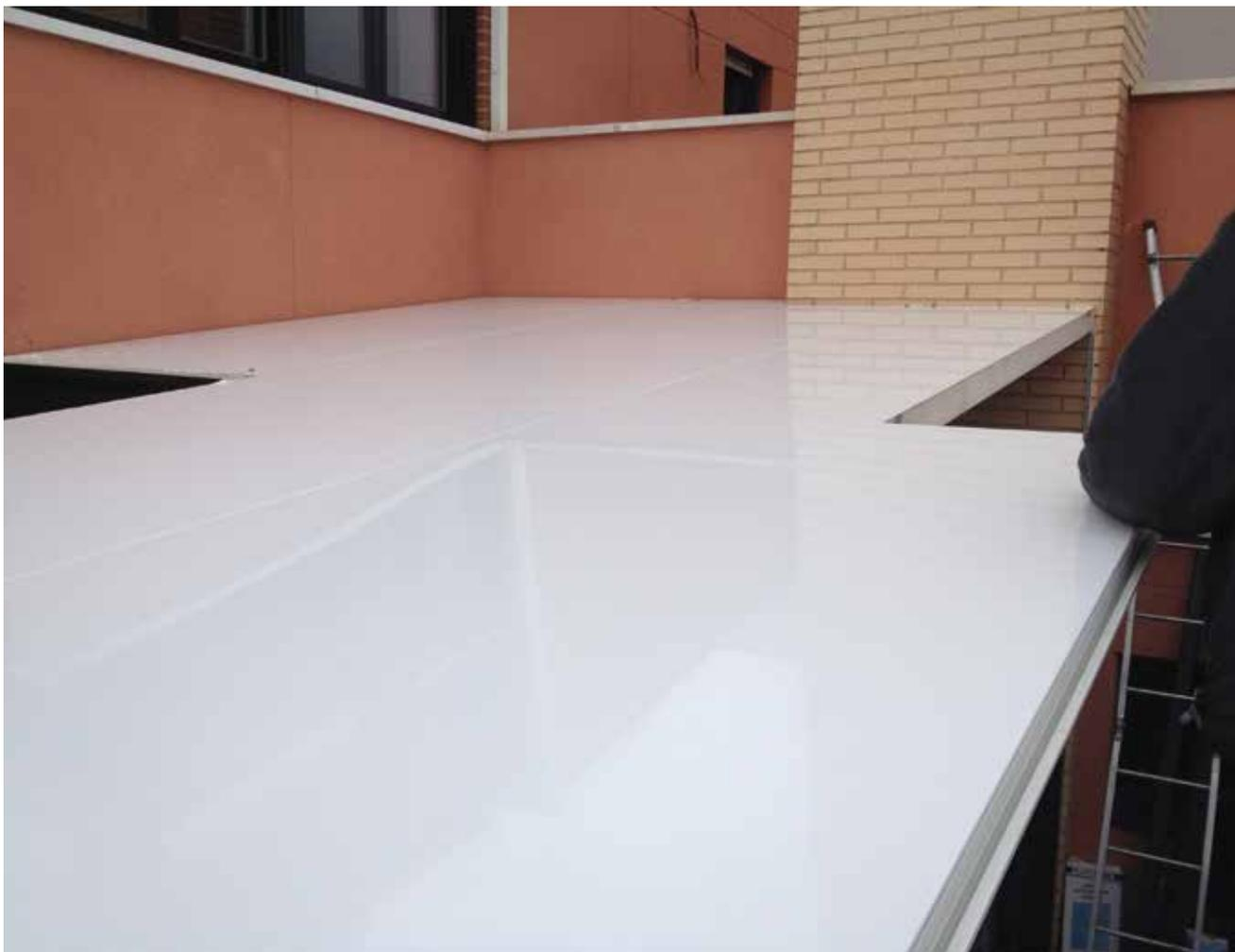
Está compuesto por dos chapas de aluminio formando un sándwich con un núcleo de poliestireno extruido (XPS) de alta resistencia a la compresión.
