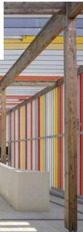
así como protección contra el deslumbramiento en las aulas con lamas orientables. En estas últimas, de idéntica sección que las fijas, no se aprecia otra diferencia que su orientación, debido a una estructura porta-lamas común a todas ellas, oculta tras las lamas.
