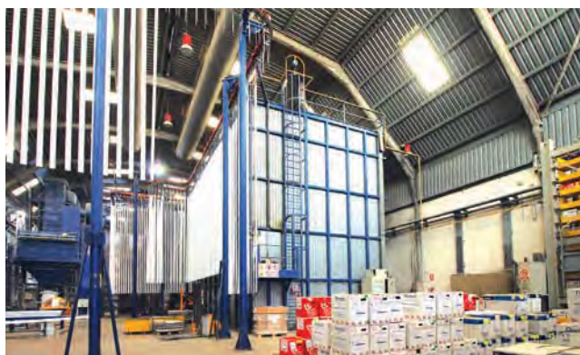
Imagen 1: La planta vertical de pintura de Aluval, proyectada por la empresa SAT de Verona, Italia.
