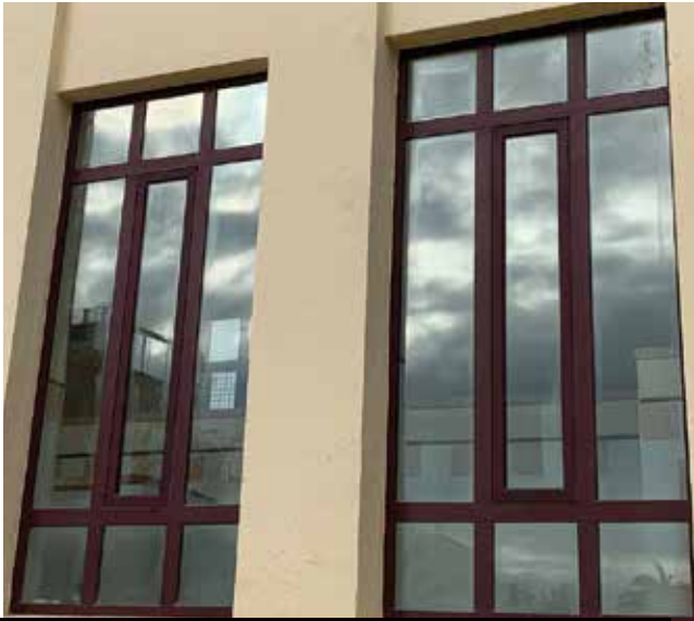
Actuación realizada en el Colegio Público Marqués de Benicarló. Fachada tratada con Façade CR-0000.
