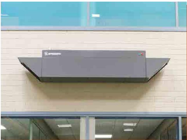
La nueva unidad de desinfección de aire Jet Cleaner se basa en estudios realizados en Estados Unidos sobre las propiedades de la radiación ultravioleta para desactivar el coronavirus, y otros virus y bacterias presentes en el aire. Para conseguir esta desinfección se utiliza radiación ultravioleta de 254 nanómetros, trabajando con una energía de 6,6 mJ/m<sup>2</sup> como mínimo.
