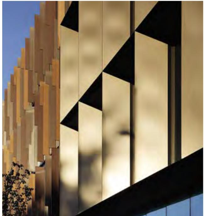
ofrece una retención de brillo significativamente mayor y una resistencia al cambio de color, combinada con la máxima integridad de la película para asegurar una protección estética y funcional a largo plazo. Interpon D2525 cumple los exigentes requisitos de calidad y resistencia a la intemperie de las principales especificaciones del mercado arquitectónico: Qualicoat clase 2, GSB Master y AAMA 2604, así como BS EN 12206.
