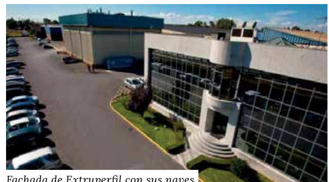
Fachada de Extruperfil con sus naves
